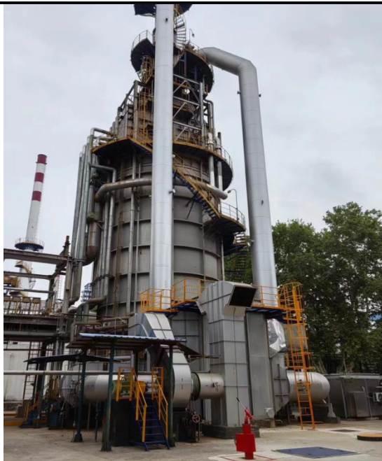
分馏塔底重沸炉 DA030 排气筒及标识牌
