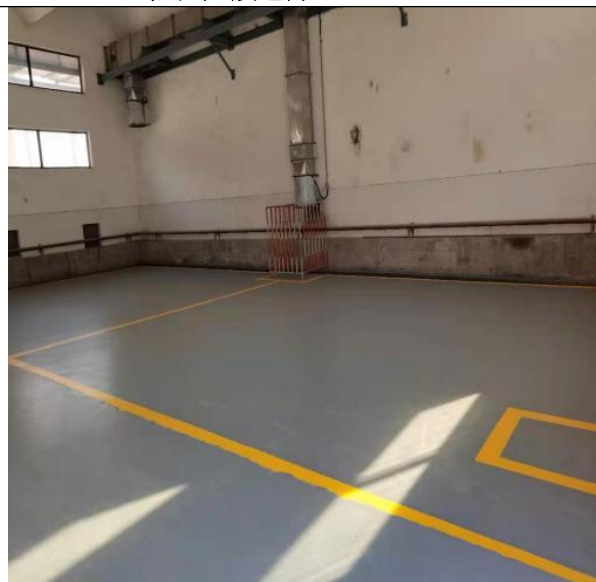
防腐防渗地坪
